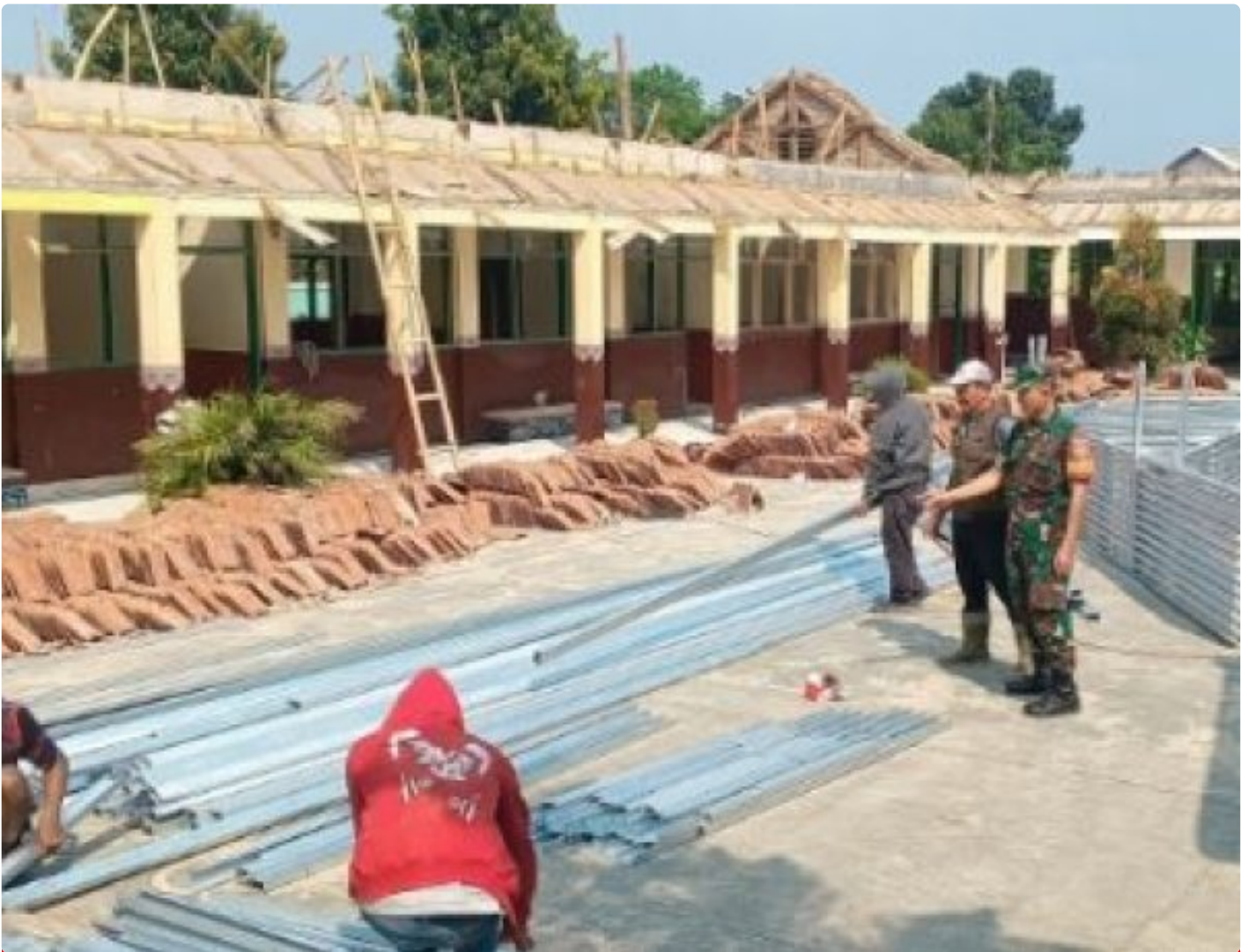
Babinsa Kalimanggis Kulon Monitoring Rehab SD Bantuan Pemerintah di Kalimanggis Kulon
